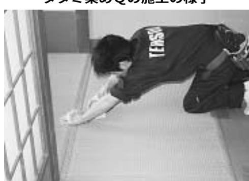
タタミ染めQの施工の様子
