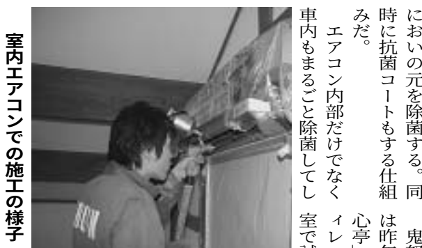
室内エアコンの施工の様子
