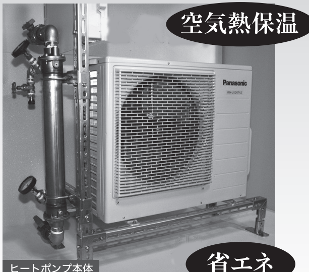
ヒートポンプ本体
