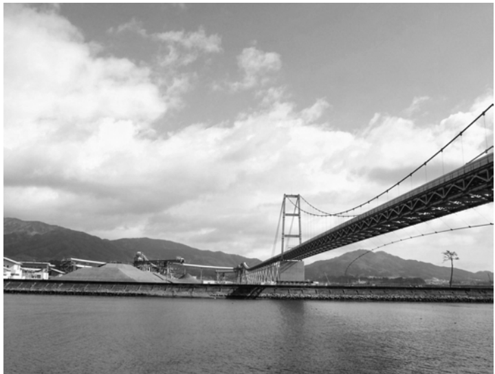
市内小学生によって命名されたベルトコンベア専用の吊り橋「希望のかけ橋」（岩手県陸前高田市）。この吊り橋を經由し掘削土は高田松原地区と高田沖の被災農地に運搬される。まるごとくくぜんたかた協議会ではベルトコンベアの始発点を見学する体験プランを実施している
