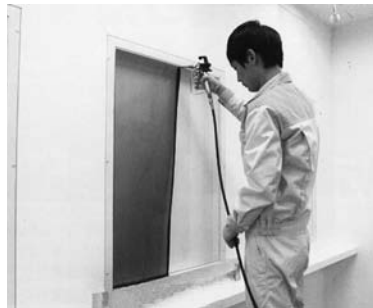
遮熱WINDOWの施工の様子
