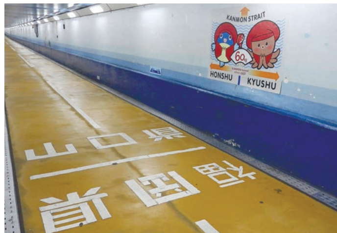
関門トンネル人道
