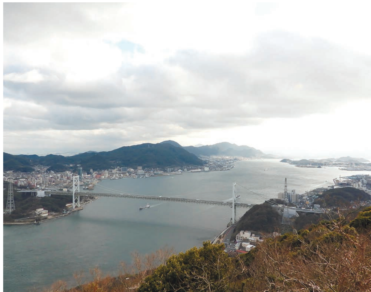
リフレッシュ工事が終わった関門橋
