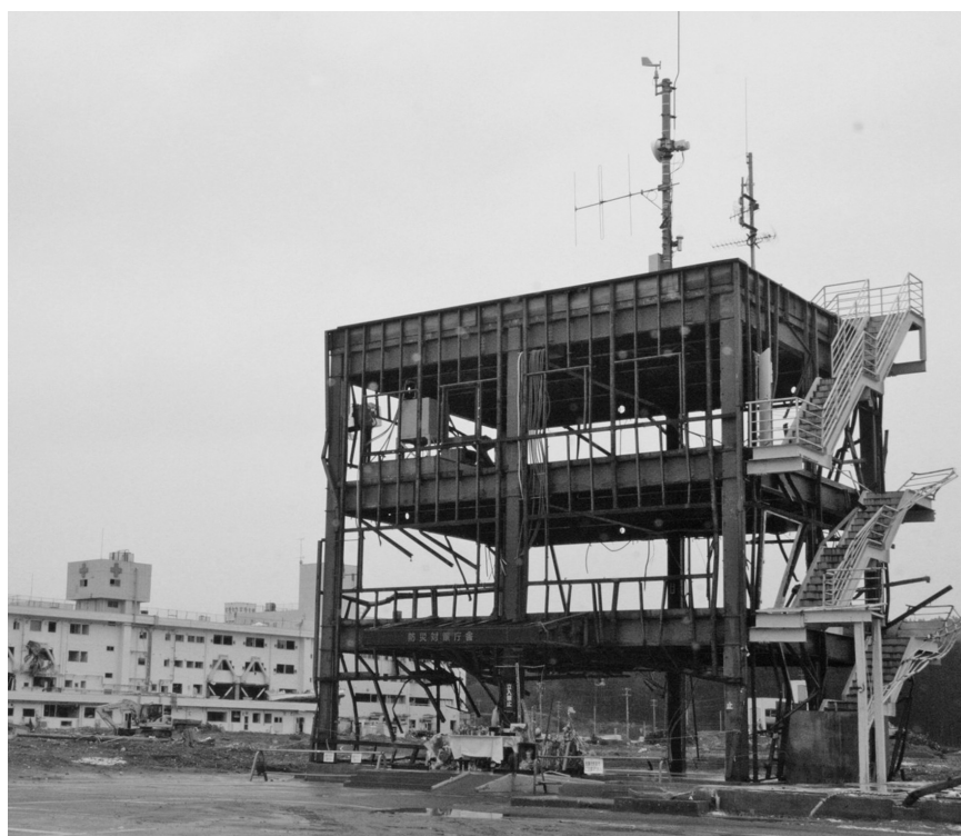
がれきが処理された庁舎(12年1月)
