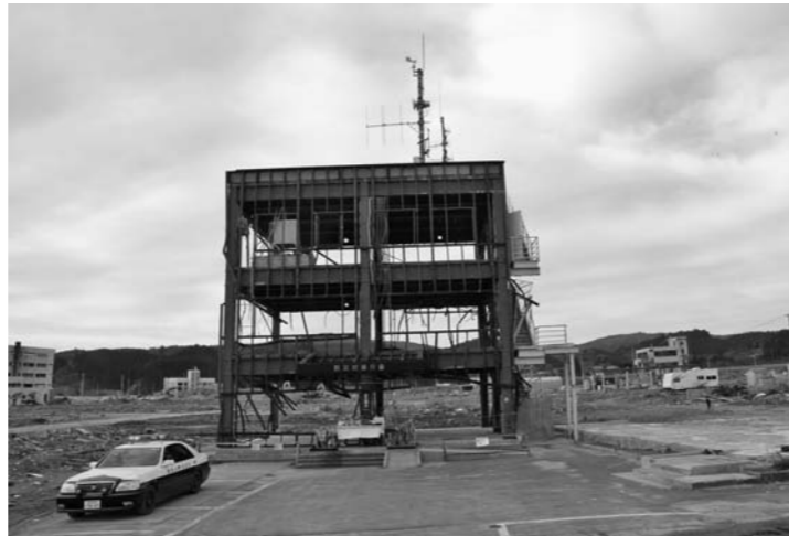
一連の震災報道で全国に知られるようになった、南三陸町役場防災対策庁舎。ガレキは取り除かれたが、曲がった鉄筋は津波の恐ろしさを伝えている
