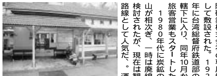
菁桐駅は古い木造駅舎が健在
