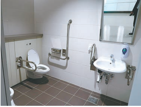
バリアフリーに対応するトイレも設置
