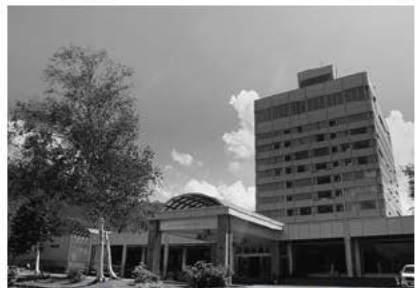
水上高原ホテル200の外観
